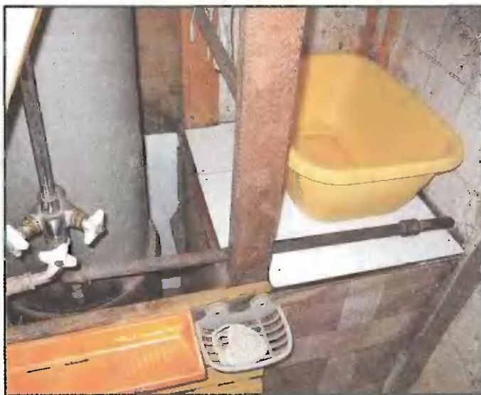
Холодная вода подводится к колонке по трубопроводу, проложенному над деревянным ящиком. Разбор горячей воды — через кран и душевую сетку. По гибкому шлангу горячая вода подается к наружной раковине
