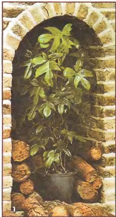
Ныне полукруглые арки в основном служат стилизационным элементом интерьера. Выложенная из кирпича ниша для цветка в виде полукруглой арки — такой же декоративный элемент, как и камин, топливник которого перекрыт подобным сводом
