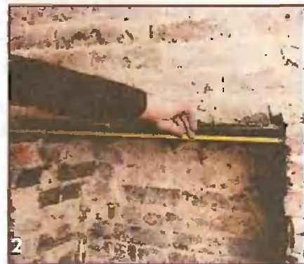
Полукруглую арку удобно возвести над нишей, если последняя уже имеется в кладке стены. Прежде всего определяют внутренние размеры ниши
