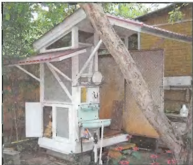
Общий вид душевой кабины
