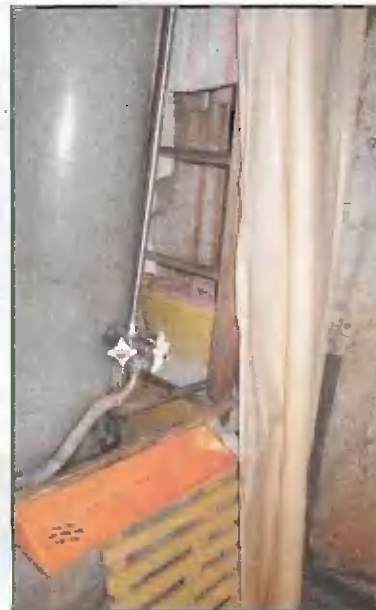
Вид душевой кабины изнутри
