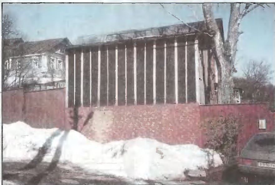
Надстройка над гаражом не украшает фасад
