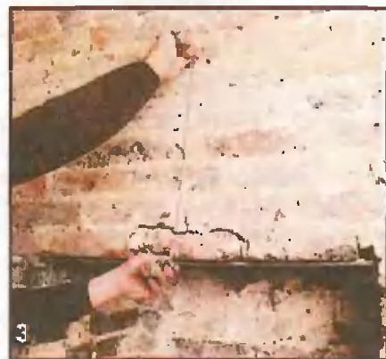
Из средней точки с помощью самодельного циркуля (привязанного к шнуру карандаша) вверх нишу проводят линию, обозначающую внутреннюю поверхность будущей арки
