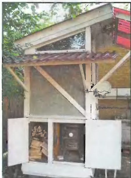
Топка колонки обращена наружу. Печка колонки и дровяной ящик закрываются дверцами
