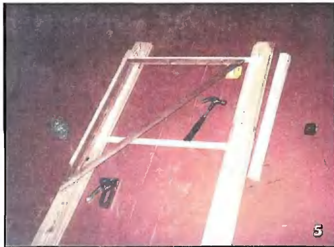
Приспособление для сборки шторы. К одной из технологических досок прибит упорный брусок. Верхнюю и нижнюю рейки крепят по угольнику
